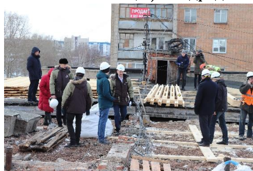
Посещение объекта капитального ремонта
