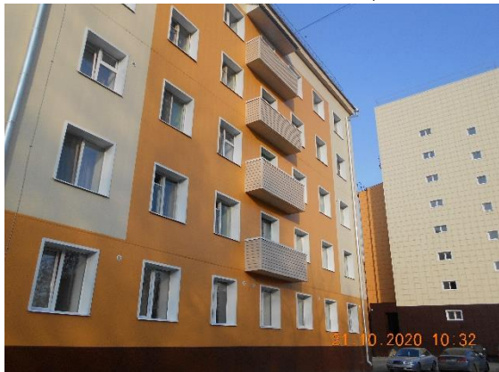
Капитальный ремонт фасада в МКД по адресу: г. Томск, пер. Светлый, д. 40
