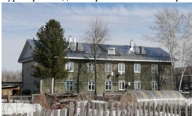
Капитальный ремонт крыши в МКД по адресу: с. Улу-Юл, ул. Железнодорожная, д. 20
