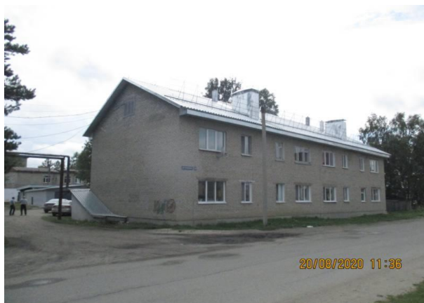
Капитальный ремонт крыши в МКД по адресу: г. Асино, ул. Челюскина, д. 15
