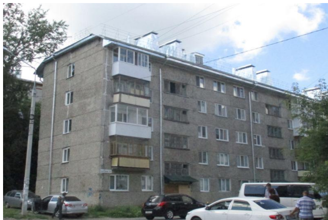
Капитальный ремонт крыши в МКД по адресу: г. Томск, ул. Карпова, д. 17
