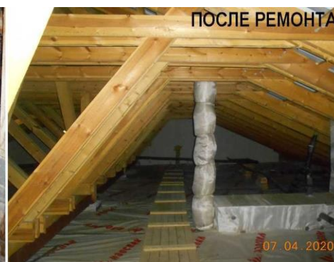
Стропильная система и чердачное пространство до и после капитального ремонта крыши в МКД
