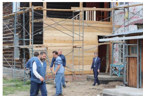
Посещение объекта капитального ремонта
