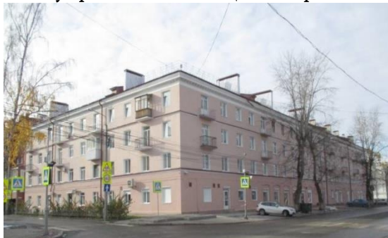
МКД по адресу: г. Томск, ул. Кузнецова, д. 1 после ремонта крыши и фасада
