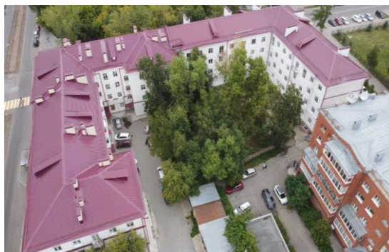
Капитальный ремонт крыши в МКД по адресу: г. Томск, ул. Кузнецова, д. 1
