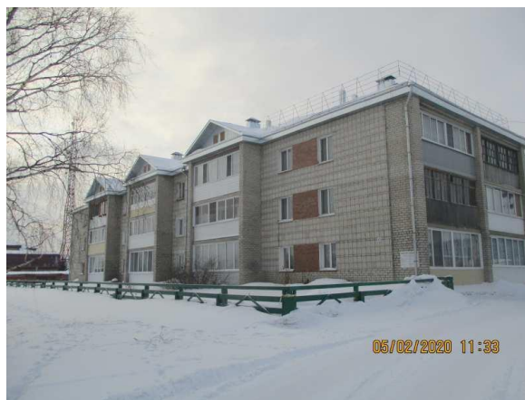
Капитальный ремонт крыши в МКД по адресу: с. Зырянское, ул. Советская, д. 40
