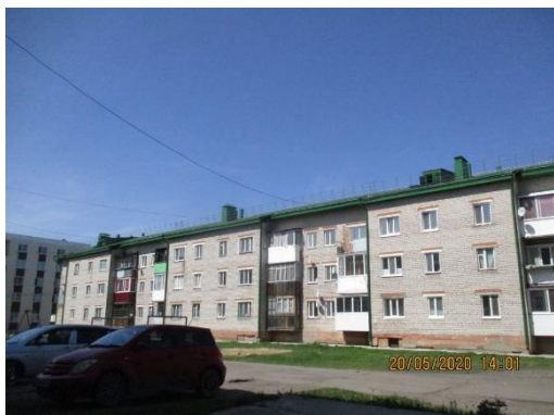
Капитальный ремонт крыши в МКД по адресу: г. Асино, ул. им. Ивана Черных, д. 18
