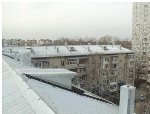
Капитальный ремонт в МКД по адресу: г. Томск, ул. Киевская, д. 86г
