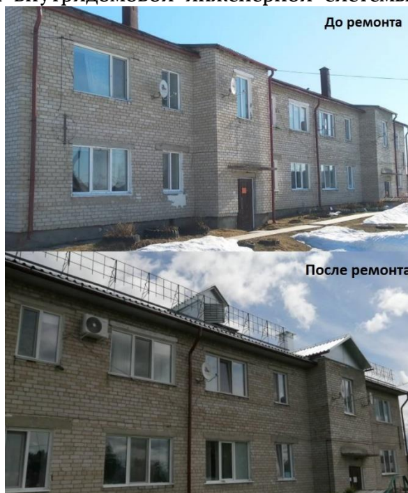
Крыша до и после ремонта в МКД по адресу: р.п. Белый Яр, ул. Таежная, д. 44
