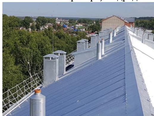
Вид крыши после ремонта в МКД по адресу: г. Томск, ул. Крымская, д. 43
