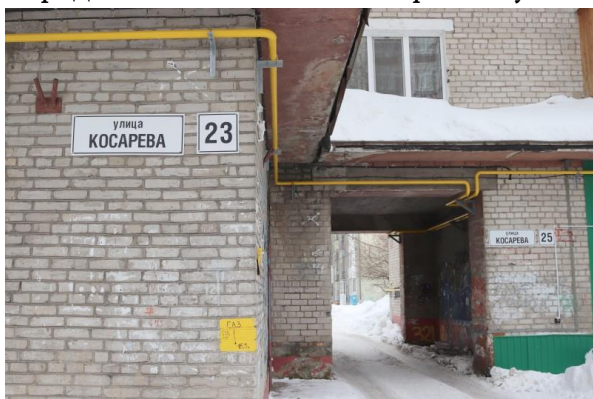
Капитальный ремонт систем газоснабжения в МКД по адресам: г. Томск, ул. Косарева д. 23 и д. 25
