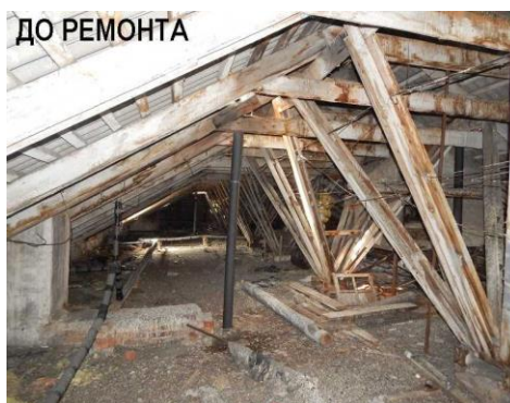
Стропильная система и чердачное пространство до и после капитального ремонта крыши в МКД
