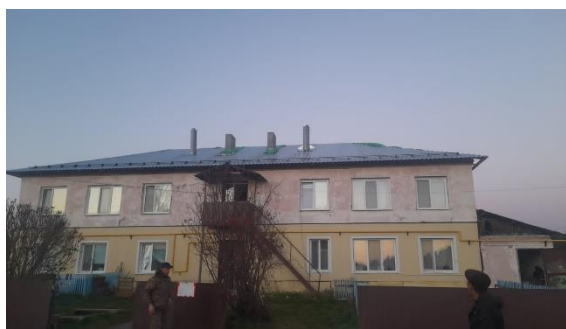
Завершаются работы по ремонту крыши в доме по адресу: с. Корнилово, Томского района, ул. Голикова, д. 12/1
