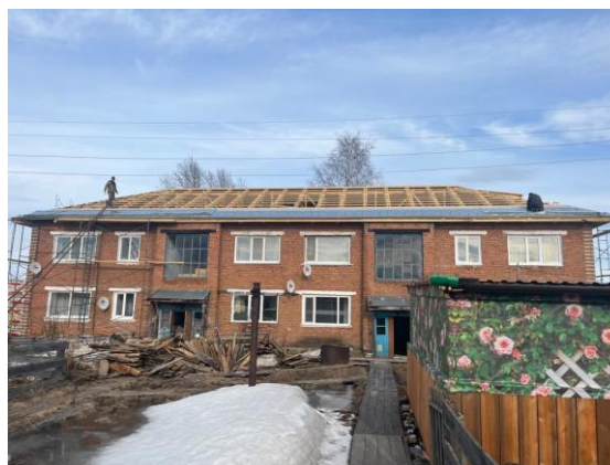
Завершается ремонт крыши в доме по адресу: с. Парабель, ул. Советская, д. 54
