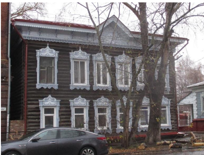
Дом по пер. Совпартшкольный, 6 в г. Томске до и после ремонта крыши. Силами подрядной организации ООО «Томский строитель» (А.К. Дубов) обновлены наличники
