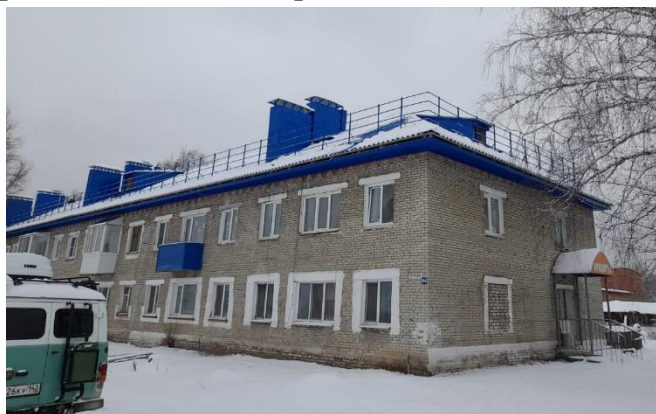
Капитальный ремонт крыши выполнен в доме по адресу: г. Асино, ул. 9 Мая, д. 64
