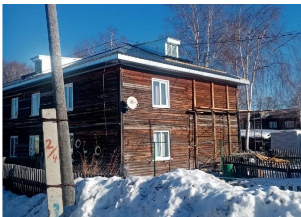
Капитальный ремонт крыши выполнен в г. Колпашево, в доме №3 по пер. Новый
