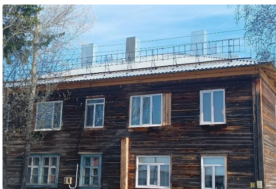
В с. Мельниково, Шегарского района, по ул. Школьная, в д.7 выполнен капитальный ремонт крыши. В ходе ремонта восстановлена кирпичная кладка печных труб
