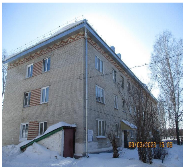
Выполнен ремонт крыши в доме по адресу: п. Копылово, Томского района, ул. Новая, д. 12
