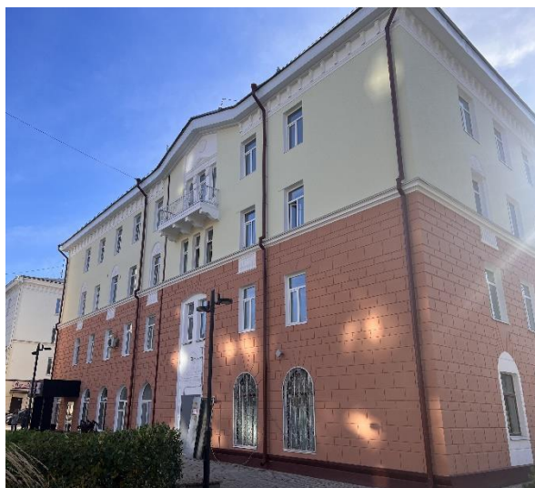
Многоквартирный дом по ул. Усова 11а в период и после проведения ремонта фасада
