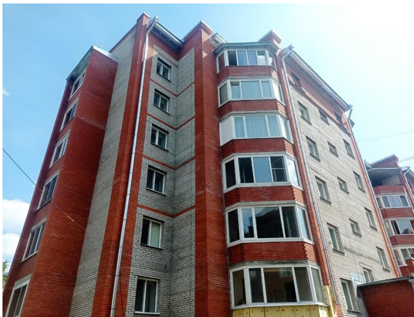
В доме по адресу: г. Томск, ул. Сибирская, д. 102/10 выполнен капитальный ремонт крыши
