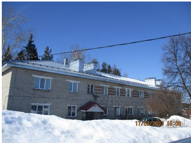
В доме с. Кафтанчиково, Томского района, по ул. Коммунистическая, д. 91 завершён капитальный ремонт крыши
