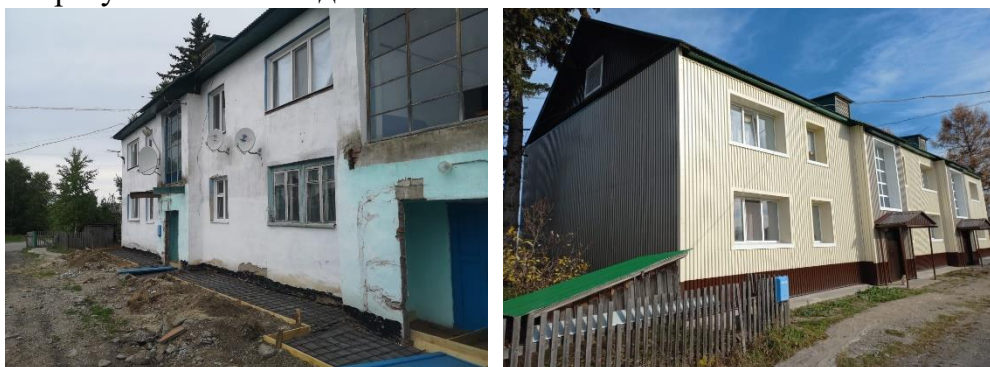
Вид дома № 59 в с. Первомайское, Первомайского района до и после выполнения ремонта фасада, стоимость работ около 4 млн.рублей
