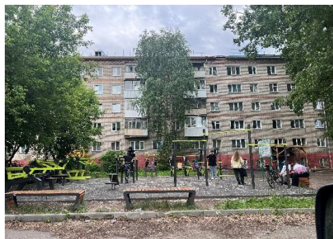
Капитальный ремонт крыши произведен в доме по адресу: г. Томск, ул. Говорова, д. 36а
