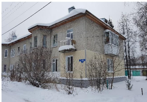
В п. Копылово, Томского района, в домах 3 и 5 по ул. Ленина выполнен ремонт внутридомовых инженерных систем тепло-, водоснабжения
