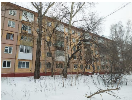
В многоквартирном доме по адресу: г. Томск, ул. Учебная, д. 19 капитально отремонтирована внутридомовая инженерная система газоснабжения
