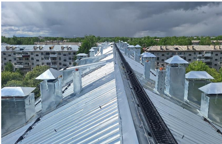
Вид сверху на отремонтированную крышу в 5-ти этажном доме по адресу: г. Северск, ул. Царевского, д. 7. В 2025 году объем выполненных работ по капитальному ремонту в МКД ЗАТО Северск составил 304,6 млн.рублей
