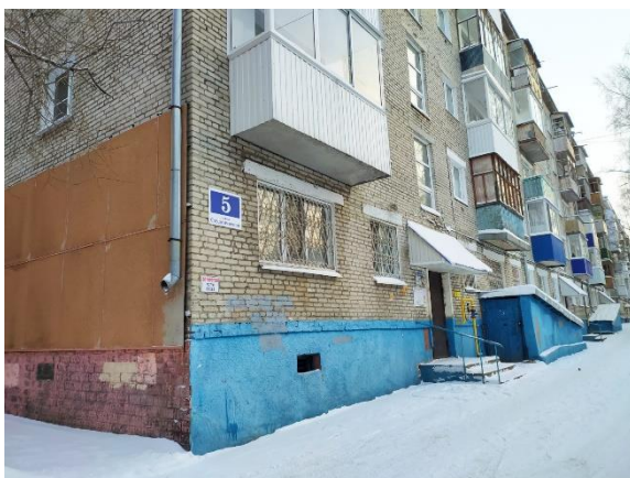
Система газоснабжения отремонтирована в МКД по адресу: г. Томск, ул. Студенческая, д. 5
