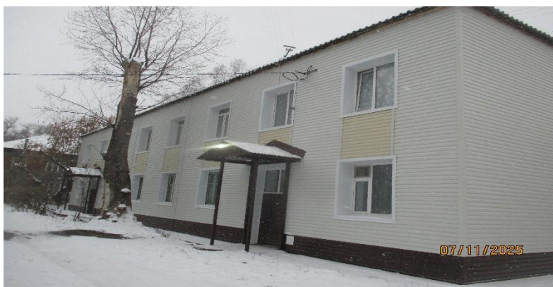
Внешний вид многоквартирного дома № 3 по ул. Любы Шевцовой в Томске до и после проведения ремонта и утепления фасада. В ходе ремонта также была полностью устроена отмостка здания
