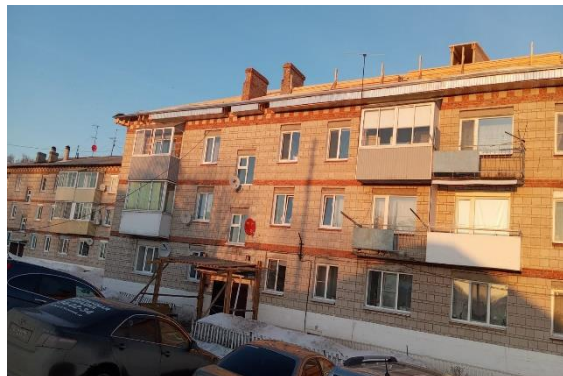
В ходе проведения капитального ремонта крыши в доме № 21 по ул. Новостройка, в с. Богашево, Томского района. Работы выполнены в 2025 году
