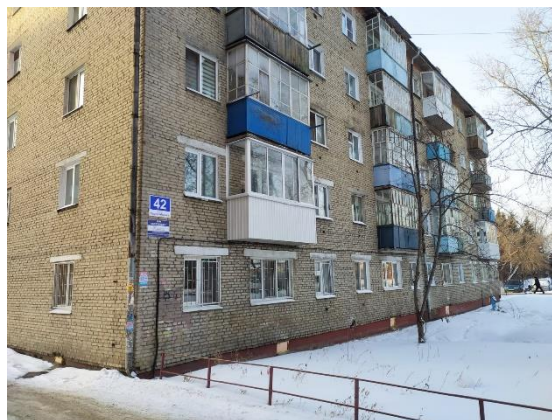
Капитальный ремонт системы газоснабжения выполнен в МКД № 42 по ул. Карла Маркса в г. Томске
