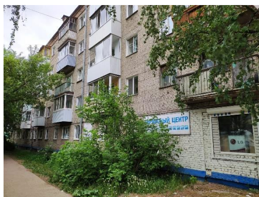
По ул. Киевской в г. Томске произведен капитальный ремонт внутридомовой инженерной системы газоснабжения в домах №№ 86а, 101, 103
