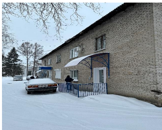
Выполнен капитальный ремонт внутридомовых инженерных систем теплоснабжения и холодного водоснабжения в многоквартирном доме по адресу: г. Томск, ул. Партизанская, д. 68
