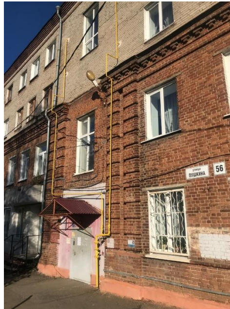
В многоквартирном доме № 56 по ул. Пушкина в г. Томске заменена система газоснабжения
