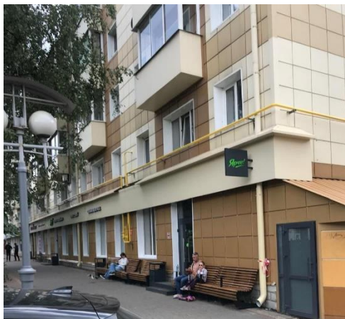
В доме № 10 по пр. Ленина в г. Томске выполнен капитальный ремонт внутридомовой инженерной системы газоснабжения
