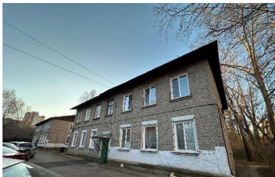
В домах №№ 44а и 44б по ул. Олега Кошевого в г. Томске выполнен капитальный ремонт внутридомовых инженерных систем теплоснабжения,
