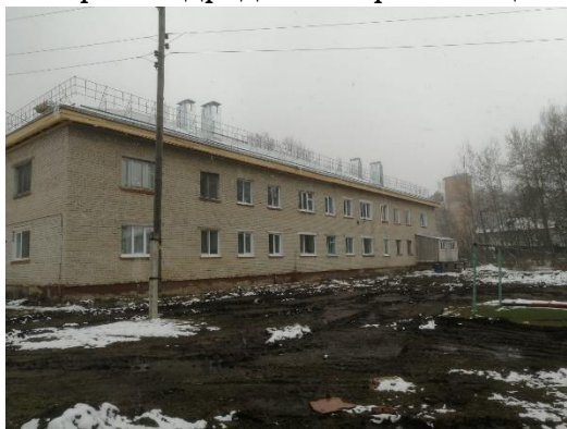
Отремонтирована крыша в МКД по адресу: д. 12, п. Рассвет, Томского района
