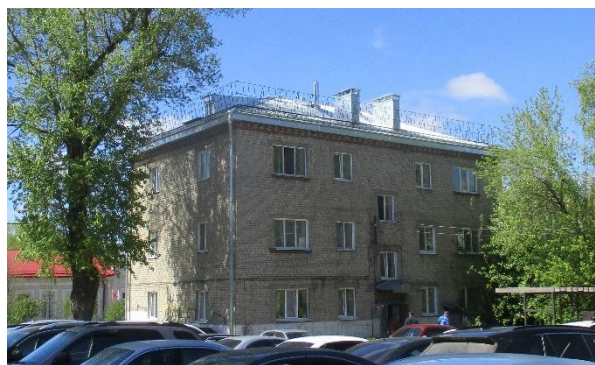
Выполнен капитальный ремонт крыши в многоквартирном доме по адресу: г. Томск, ул. Красноармейская, д. 82
