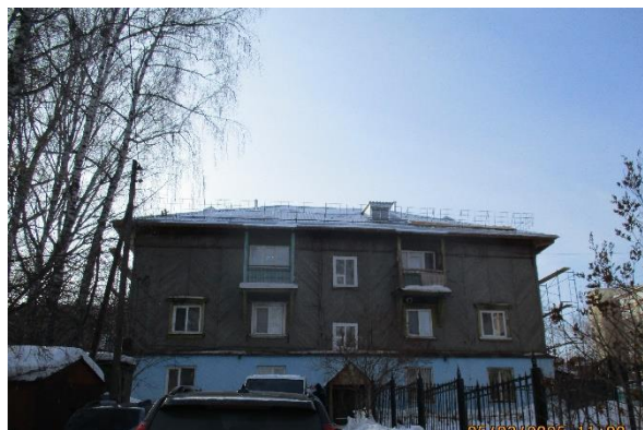
В МКД № 17 по ул. Карташова в Томске завершен капитальный ремонт крыши
