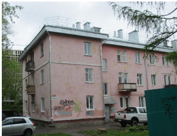
Завершен капитальный ремонт крыши в многоквартирном доме № 5а по ул. Артема в г. Томске
