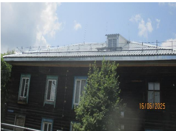
Крыша до и после капитального ремонта в многоквартирном доме № 10 по ул. Алеутская в г. Томске
