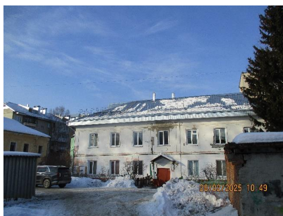
Капитально отремонтирована крыша в многоквартирном доме по адресу: г. Томск, ул. Студенческая, д. 49
